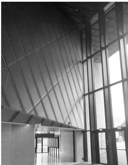
Fot. 6.5.2. Okładzina wykończeniowa wewnętrznej pionowej przegrody wykonana z aluminiowej siatki cięto-ciągnionej jako element korygujący akustykę wnętrza i integrujący formalnie środowisko zamknięte z zewnętrzną przegrodą, której okładzina jest wykonana z identycznego materiału budowlanego. Centrum Kongresowe, Katowice, proj. JEMS Architekci, fot. M. Celadyn, 2015.
