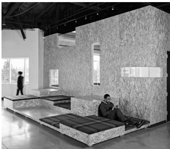
Fot. 7.4.2.2. Struktury przestrzeni ogólnodostępnej rekreacyjnej skonstruowane z elementów konstrukcyjnych drewnianych i wykończeniowych z płyt OSB o zredukowanej zawartości formaldehydu. Biuro firmy AOL, Palo Alto, USA, 2011, proj. Studio O+A, fot. J. Sanidad. Źródło: http://www.dezeen.com./2011/06/09/aol-offices-by-studio-oa [dostęp: 19.09.2014].
