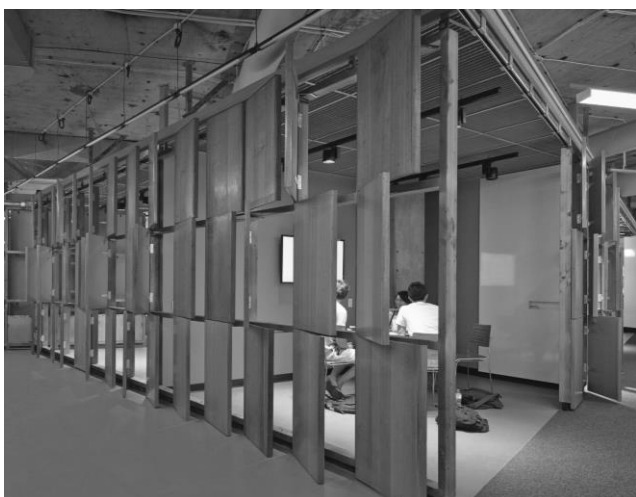
Fot. 7.4.1.3. Mobilne przegrody ażurowe stref przeznaczonych dla grup dyskusyjnych wykonane z odzyskanych i odnowionych blatów szkolnych stolików; nowy kontekst i funkcja sprzętów w pomieszczeniach biblioteki uniwersyteckiej. MUSE, Melbourne, Australia, 2014, proj. Woods Bagot, fot. P. Bennetts. Źródło: http://www.archdaily.com/493677/muse-woods-bagot [dostęp: 9.04.2015].
