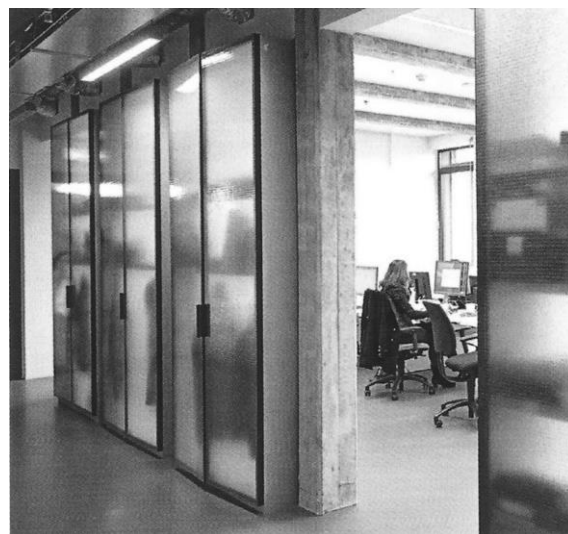
Fot. 3.5.1. Wewnętrzne przegrody – elementy umeblowania instalowane jako szafy ubraniowe i biurowe pomiędzy słupami konstrukcyjnymi w modernizowanej przestrzeni biura. Montaż elementów wykonanych ze szkieletu oraz przeszklonych paneli drzewiowych umożliwia ich łatwą relokację; przejrzyste wykończenie zapewnia transmisję światła naturalnego w głąb przylegającej do stanowisk pracy strefy cyrkulacji; renowacja pomieszczeń biurowych w budynku Timmerhuis, proj. OMA, Rotterdam, Holandia, fot. OMA, 2015. Źródło: „Detail Green”, Institut fuer internationale Architektur – Dokumentation GmbH & Co. KG, München, nr 5/2016, 2016, s. 416.
