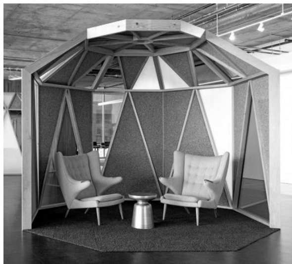
Fot. 6.1.1.1. Struktury przestrzenne, pawilony w szkielecie drewnianym przeznaczone do nieformalnych konsultacji i odpoczynku w strefie rekreacji; inspirowane namiotami nomadów i tak określane przez projektantów ( yurts ), wykończone poliwęglanem i wykładzinami filcowymi. Biuro firmy Cisco, San Francisco, USA, 2013, proj. Studio O+A, fot. J. Sanidad. Źródło: www.archdaily.com/469722/meraki-now-cisco-offices-studio-o-a/52df3303e8e44e9f1400017c-meraki-now-cisco-offices-studio-o-a-photo [dostęp: 10.08.2014].
