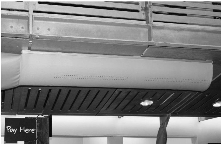
Fot. 4.2.3.1. Przewody wentylacyjne nawiewne ( textile diffuser ) wykonane z tworzywa pochodzącego z postkonsumpcyjnego recyklingu (recyklowane tworzywo sztuczne PET uzyskane ze zużytych opakowań), redukujące poziom hałasu i wibracji z instalacji wentylacyjnych. Mikroperforacja zapewnia równomierne rozprowadzenie powietrza wewnątrz pomieszczenia i komfort termiczny, redukuje osadzanie się pyłów. Producent systemu Prihoda, źródło: http://www.prihoda.com/userfiles/documents/case_study/eden_project_eng_pdf [dostęp: 3.10.2015].
