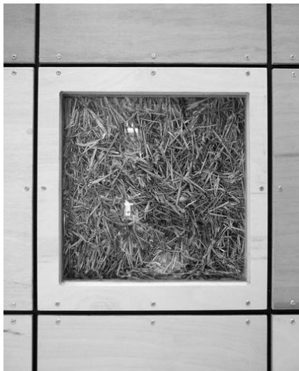
Fot. 4.3.2.1. Fragment przegrody zewnętrznej z widoczną wewnątrz pomieszczenia, poprzez zainstalowaną osłonę z panelu szklanego, warstwą izolacji termicznej wykonaną z bali naturalnej słomy wypełniających prefabrykowaną szkieletową drewnianą konstrukcję. Kawiarnia uniwersytecka Holme Lacy, Herefordshire, UK, 2011, proj. Hewitt Studios LLP, fot. Hewitt Studios LLP. Źródło: http://www.hewittstudios.co.uk/architecture_item.php?id=4 [dostęp: 2.12.2015].
