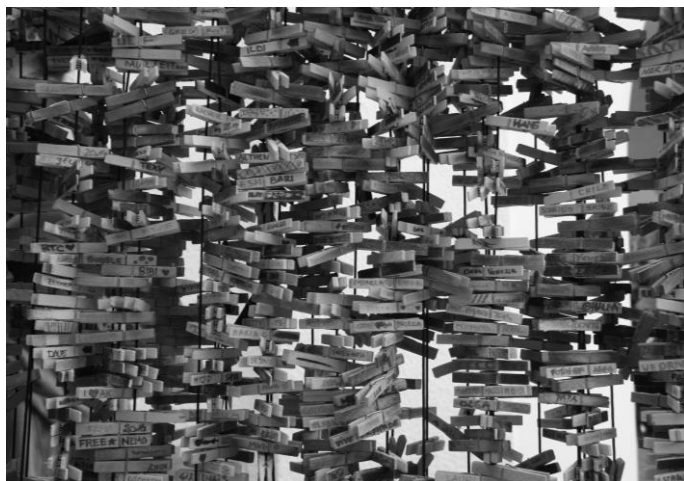
Fot. 8.2. Ażurowa subiektywna przegroda rozdzielająca przyległe strefy wnętrza, wykonana z zużytych i odzyskanych drewnianych klipsów mocowanych na stalowych linkach stabilizujących, przytwierdzonych do drewnianego stelażu. Pawilon ekspozycyjny egipski, XIV Międzynarodowe Biennale Architektury, Wenecja, Włochy, 2014, fot. M. Celadyn.
