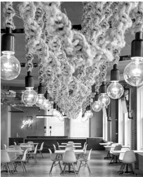
Fot. 6.5.1. Sufit podwieszony w strefie konsumpcyjnej biura. Podwieszane maty filcowe z wełny naturalnej gr. 5 mm, uzupełnione sznurami z naturalnego surowca służącymi do mocowania opraw oświetleniowych. Biuro YELP, San Francisco, USA, 2013, proj. Studio O+A, fot. J. Sanidad. Źródło: http://www.archdaily.com/517354/yelp-headquarters-studio-o-a/539fea59c07a80fed50000ce-yelp-headquarters-studio-o-a-photo [dostęp: 24.06.2015].
