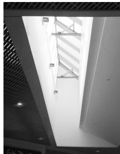
Fot. 4.3.1.1. Studnia doświetlająca strefę komunikacyjną w przestrzeni komercyjnej wykonana w formie świetlika z przeszkloną nachyloną płaszczyzną o orientacji południowej oraz pionową płaszczyzną wykończoną materiałem refleksyjnym. Centrum handlowe, Katowice, fot. M. Celadyn, 2015.
