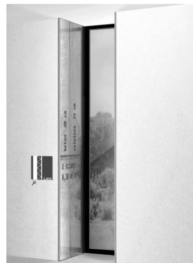
Rys. 4.3.2.2. Warstwy struktury przegrody zewnętrznej widoczne w stanie naturalnym poprzez osłonę ze szklanego panelu w miejscu okładziny wykończeniowej wnęki okiennej. Budynek 3E Politechniki Wrocławskiej, proj. P. Kuczia. Źródło: P. Kuczia.
