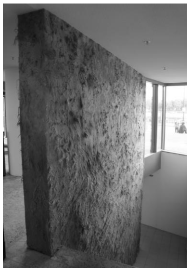
Fot. 4.1.1. Okładzina ścienna wykonana z naturalnej wełny owczej, pochodzącej z hodowli ekologicznych i barwionej naturalną substancją wytworzoną na bazie łusek cebuli. Hall wejściowy Centralnej Biblioteki Publicznej, Amsterdam, Holandia, arch. Jo Coenen, proj. okładziny wykończeniowej ściany wewnętrznej Claudy Jongstra, 2006, fot. M. Celadyn, 2014.
