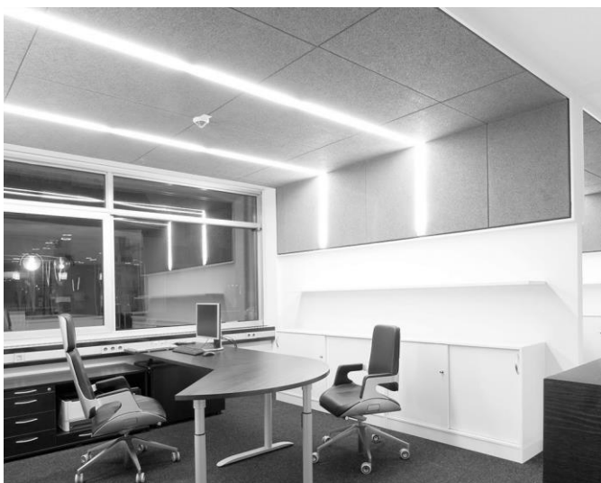
Fot. 6.2.1. Pomieszczenia biurowe typu private office z sufitem podwieszonym wykonanym z płyt z włókna drzewnego zespolonego magnezem serii Heradesign. Citizens Advice Bureau, Weinstadt, Niemcy. Źródło: http://www.architectureanddesign.com.au/getattachment/5f3229dd-bb91-4baf-8819-b736938b220c/attachment.aspx [dostęp: 12.02.2016].
