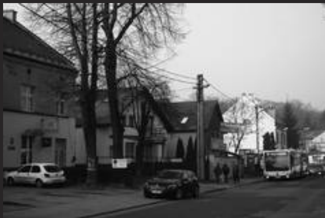
Fot. 1. Dogęszczanie zabudowy usługowej przy ul. Królowej Jadwigi 240 i 242, nierespektujące okapowego charakteru linii zabudowy wyznaczonej istniejącymi budynkami – stan z listopada 2014 (fot. W. Chmielewski)
